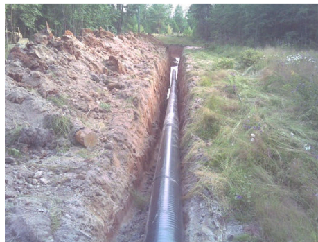
Рисунок 2 – Строительство газопровода
