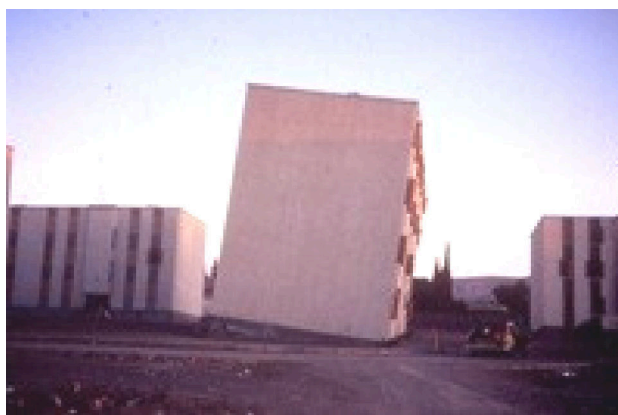
Рисунок 1 – Осадка здания
