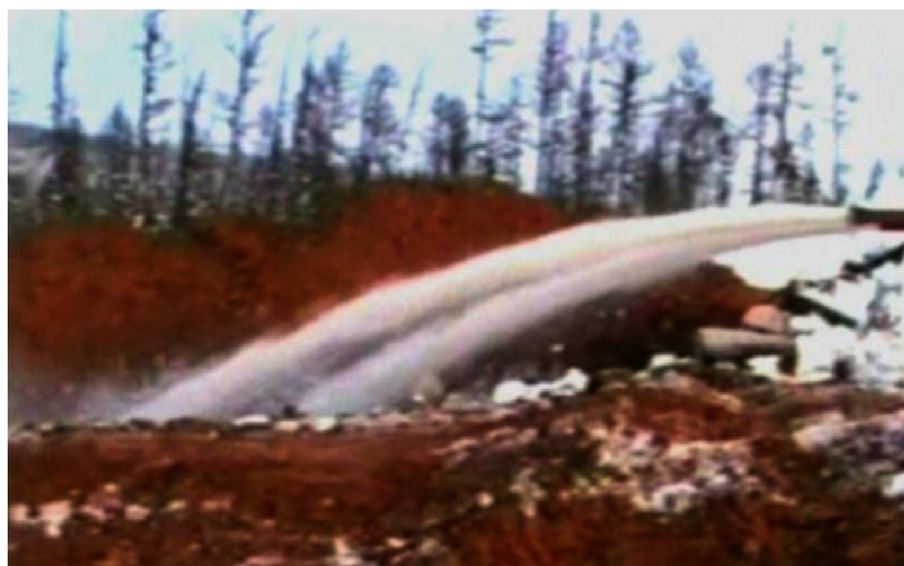
Рисунок 6 – При аварийном фонтанировании скважины ПВО закрыто, рапа с дебитом 5300 \text{ м}^3/\text{сут.} по выкидным линиям перепускается в аварийный амбар Фото С.А. Молчанова, скважина № 18 Ковыктинская (2018 год)
