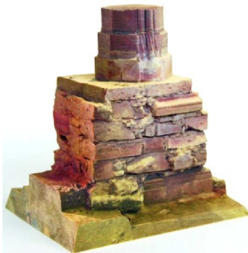
Рисунок 6 – 3D модель колонны созданная по облаку точек снятому Leica ScanStation C10
